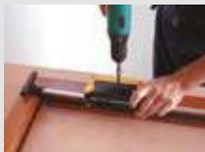
**5** - Nachher wird die Bohrung auf die Zarge gemacht.
