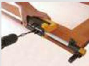
**6** - Der Vorgang für die Flügel ist gleich, d.h. der externe Verschluss wird auf dem Türflügel positioniert und dann wird gebohrt.
