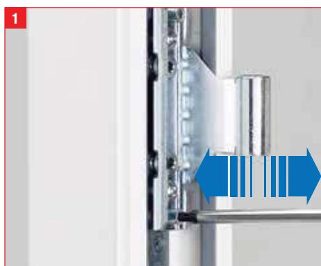
**1.** Le réglage en profondeur du vantail s'effectue en agissant sur la partie femelle de la charnière.
