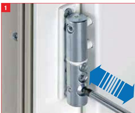
**1.** Le réglage en profondeur du vantail s'effectue en agissant sur la partie mâle de la charnière.
