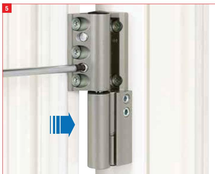
**5.** Le réglage en profondeur ou compression du joint, +-1,5mm, se fait sur la partie vantail.
